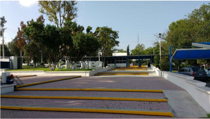
Figura 8. Edificio que ocupa actualmente la Escuela Normal del Estado de Querétaro, a partir de 1975 (San Mateo S/N Col. Vista Alegre).
