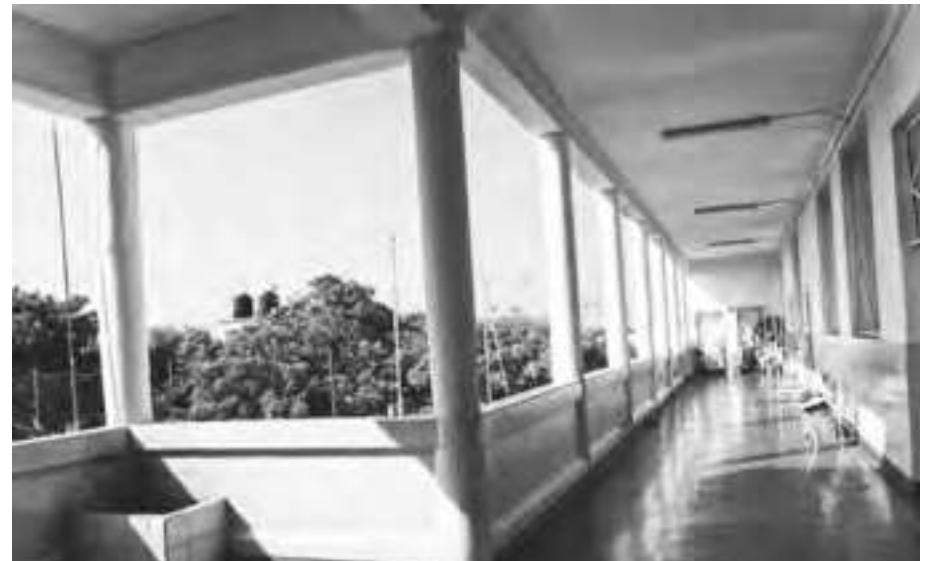
Imagen 17. Los pasillos dan sombra a las aulas
