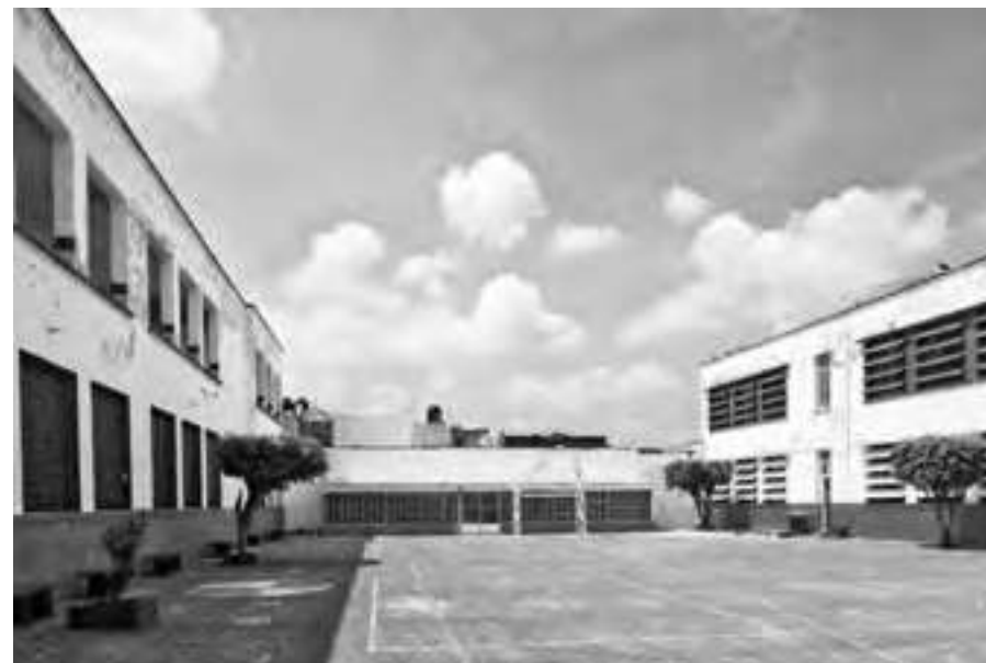
Imagen 26. Patio interior de la escuela Julio S. Montero
