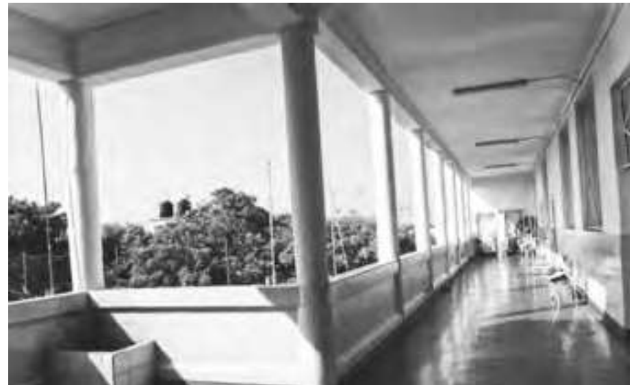
Imagen 17. Los pasillos dan sombra a las aulas
